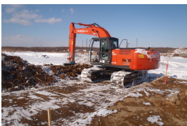
冬期土工の施工状況
