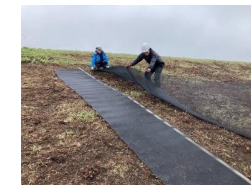
メッシュシートの敷設
