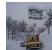
片持式の雪落とし作業
