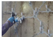
ひび割れ注入工法
