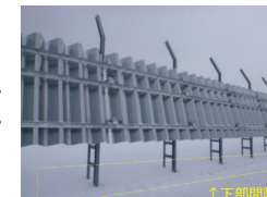
設置状況(石狩吹雪実験場)
