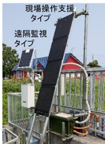
樋門への設置状況（厚別川）
