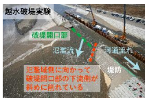
千代田実験水路を用いた実物大規模の越水破堤実験
