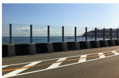
設置状況 (一般国道42号 和歌山県すさみ町)
