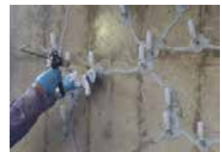
ひび割れ注入工法
