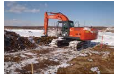
冬期土工の施工状況
