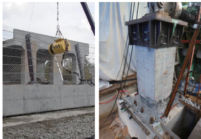
落石防護柵の実規模衝突実験
