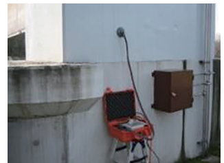
頭首工における補修・補強工法の耐久性調査
