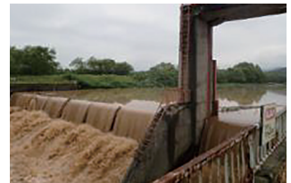
濁水が流下する頭首工付近の状況
