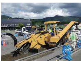
国道でのトレンチャーによる掘削施工試験状況
