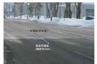
機能性SMAの冬期路面時の状況例
