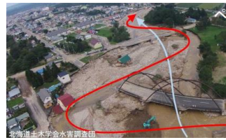
側方侵食による被災
