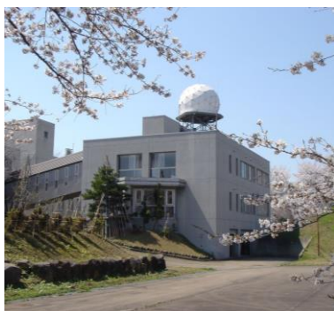
②雪崩・地すべり研究センター 雪崩災害、地すべり災害などの防止に関する様々な研究開発を実施
