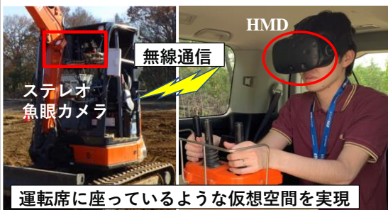
VR技術を活用した無人化施工
