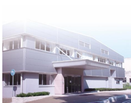
⑤水災害・リスクマネジメント国際センター 日本政府とユネスコの協定に基づき設置。 土木研究所・本館に隣接。
