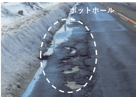
融雪期に発生する凍結融解の繰り返し等により舗装が損傷
