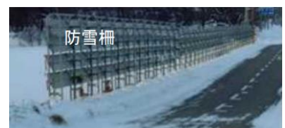
吹雪対策施設
