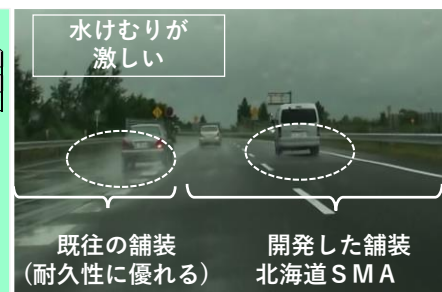
開発した舗装の施工箇所の状況
