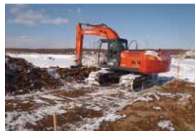
冬期土工の施工状況
