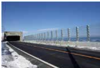
設置状況 (一般国道336号)
