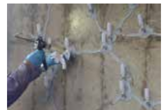
ひび割れ注入工法
