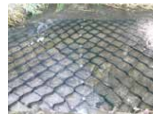
ネットの施工状況
