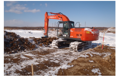
冬期土工の施工状況
