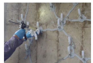
ひび割れ注入工法
