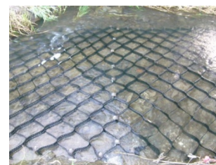
ネットの施工状況
