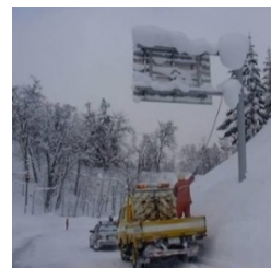
片持式の雪落とし作業
