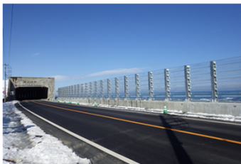
設置状況 (一般国道336号)
