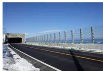
設置状況 (一般国道336号)
