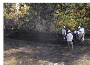
ネットの施工状況
