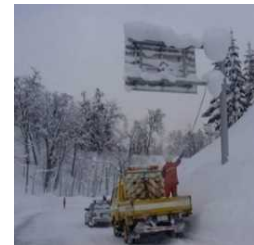
片持式の雪落とし作業
