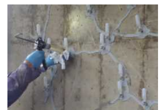
ひび割れ注入工法
