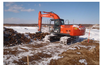
冬期土工の施工状況
