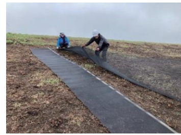
メッシュシートの敷設
