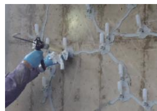
ひび割れ注入工法
