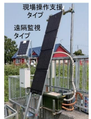
樋門への設置状況（厚別川）
