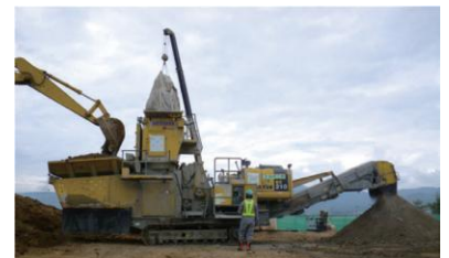
対策事例：移動式プラントによる改良
