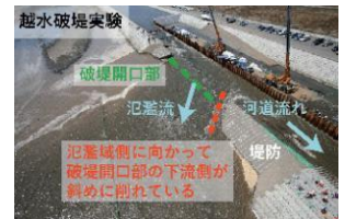
千代田実験水路を用いた 実物大規模の越水破堤実験
