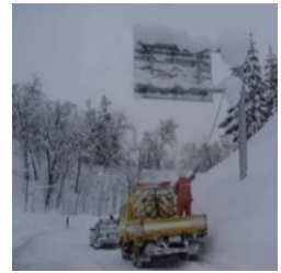
片持式の雪落とし作業
