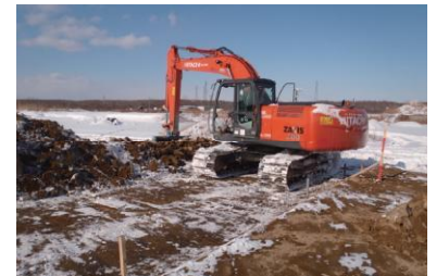
冬期土工の施工状況
