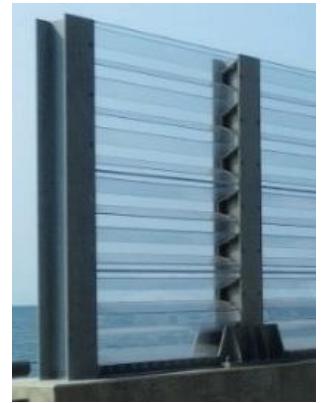
道路側から見た柵の形状
