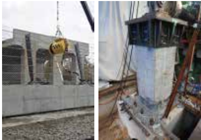
落石防護柵の実規模衝突実験
