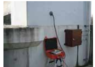
頭首工における補修・補強工法の耐久性調査
