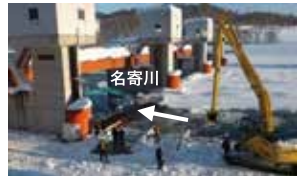
重機による水道取水口付近のアイスジャム（晶氷）除去（名寄市提供）
