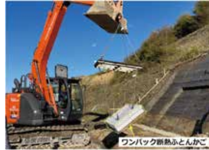
施工性と安全性に優れた切土のり面の凍上対策
