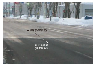
機能性SMAの冬期路面時の状況例
