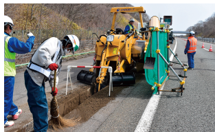
道央自動車道でのトレンチャーによる掘削施工状況
