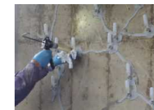
ひび割れ注入工法
