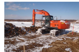
冬期土工の施工状況
