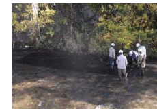
ネットの施工状況
