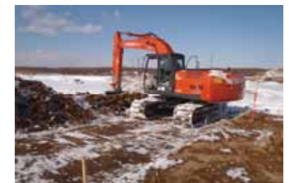
冬期土工の施工状況
