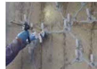
ひび割れ注入工法
