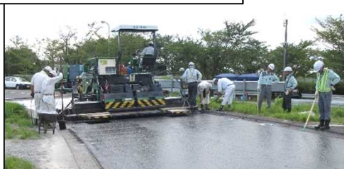
樹脂防水材料施工状況
