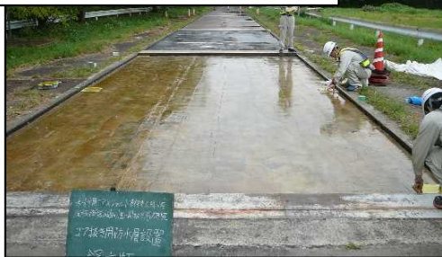
樹脂防水材料施工状況
