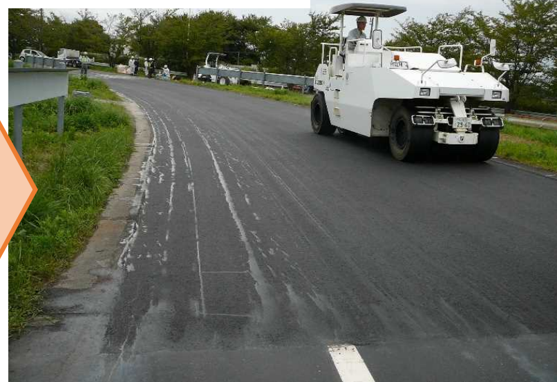
④表層の敷均し
