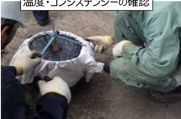
温度・コンシステンシーの確認
