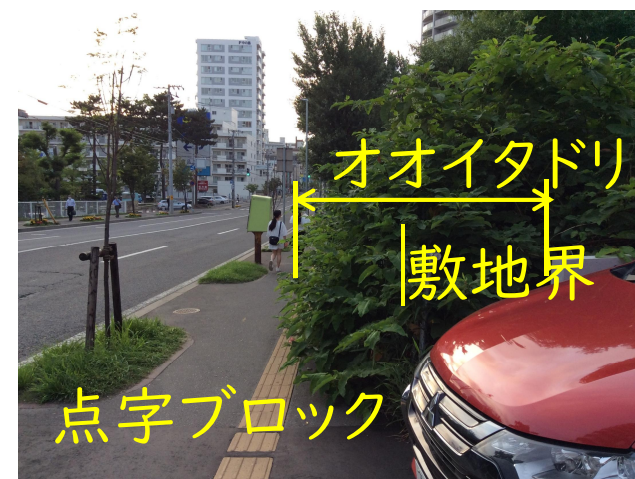
点字ブロックへの支障
