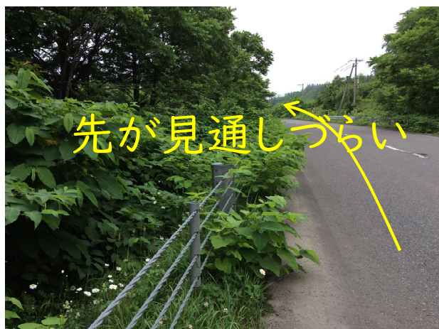
曲線部での視程障害
