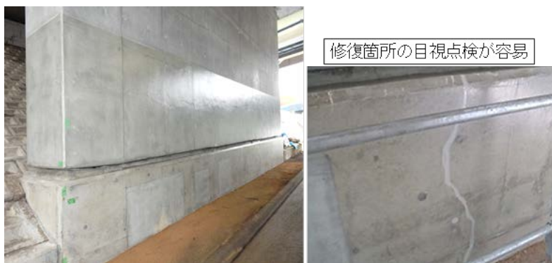
←道路橋下部工での施工例
