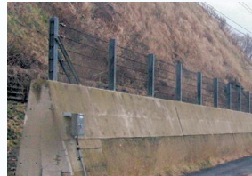
落石防護施設（擁壁、柵）
