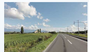
電柱を左から右に移設した景観向上策
