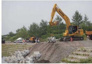
堤防決壊時の緊急締切作業実験
