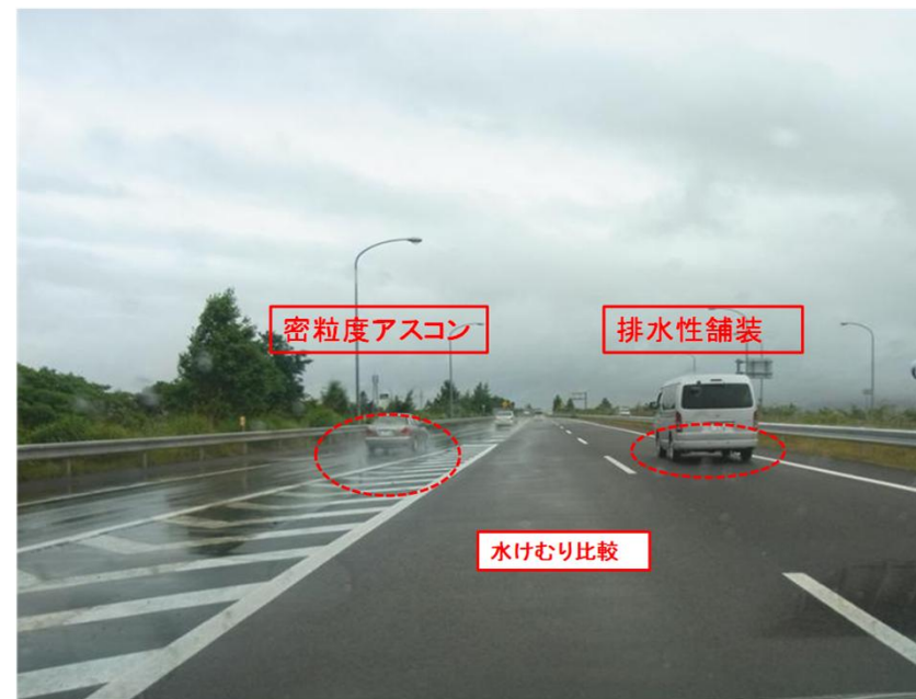
走行車の水けむりの比較 (密粒度アスコンと排水性舗装)
