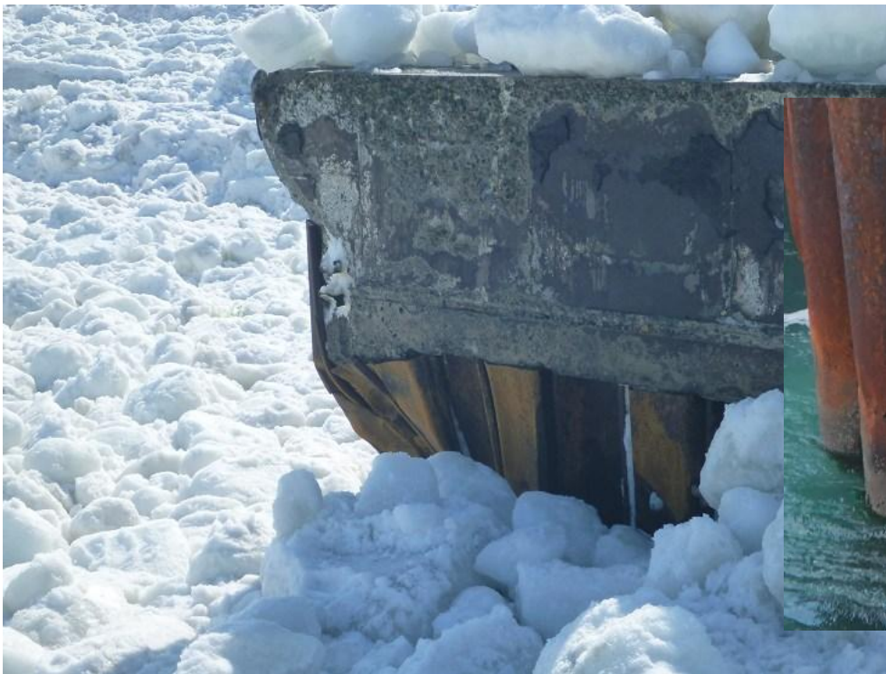
オホーツク海に面した導流堤
