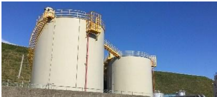
石油タンクの例（道東）
