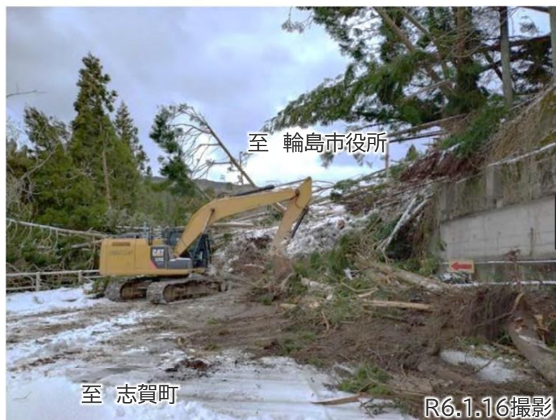
崩壊箇所の啓開作業状況
