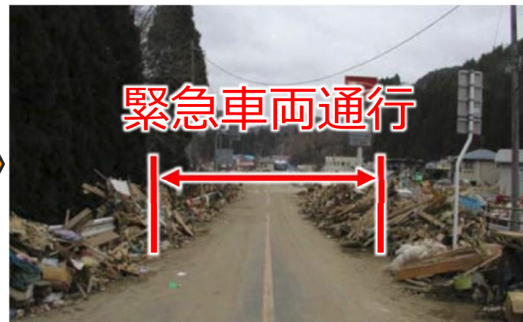
道路啓開作業後
