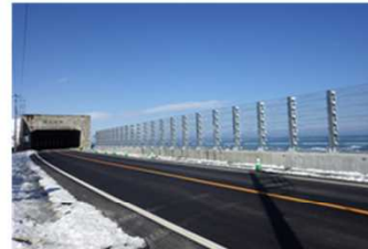
設置状況(一般国道336号)
