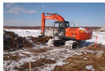
冬期土工の施工状況
