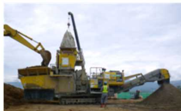
対策事例：移動式プラントによる改良
