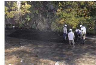
ネットの施工状況
