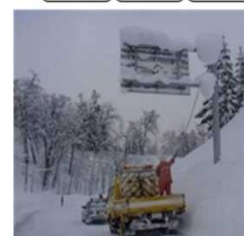
片持式の雪落とし作業
