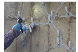
ひび割れ注入工法
