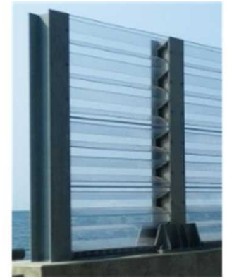
道路側から見た柵の形状
