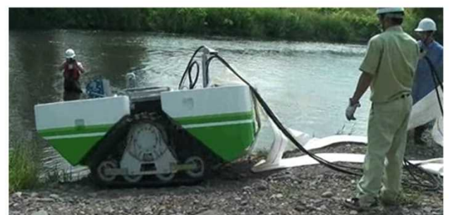
訓練での運転状況
