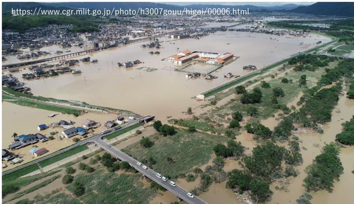
西日本豪雨における堤防決壊の状況 (高梁川水系小田川 岡山県倉敷市真備町)
