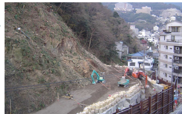
応急対策工事
