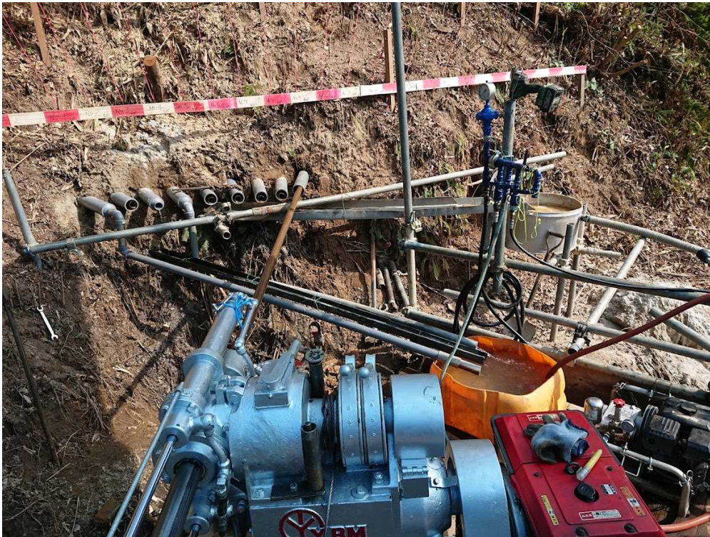
応急横ボーリング工の施工
