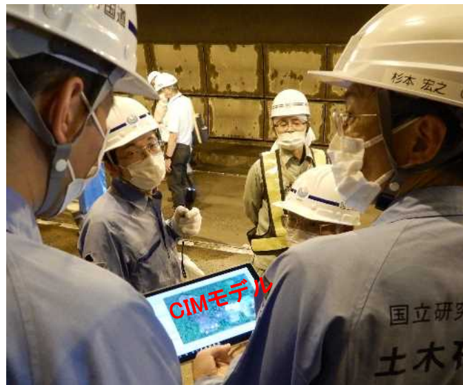
地すべりとトンネル位置の確認
