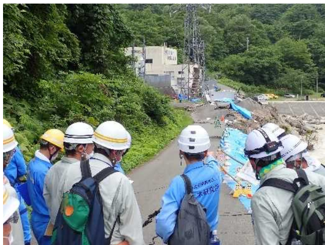
緊急的な現地調査
