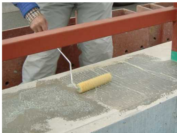
施工の一例(道路橋地覆)
