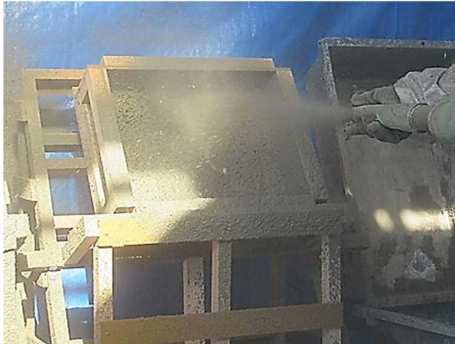
パネル型枠の供試体作製状況
