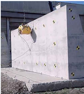
落石防護擁壁の実規模衝突実験
