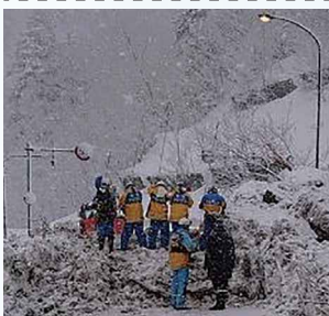
雪崩及び岩盤崩壊による災害
