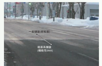
機能性SMAの冬期路面時の状況例
