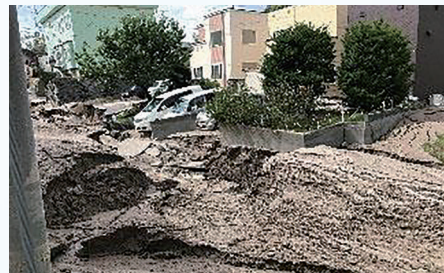
火山灰質土による 谷埋め盛土の液状化被害
