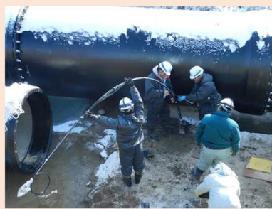
層別沈下計の設置作業
