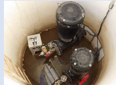
水圧・加速度センサの設置
