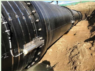
変位計の設置状況
