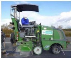
大型車対応ランブルストリップス施工時の状況
