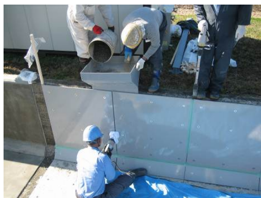
側壁打設状況
