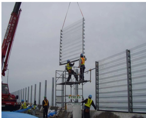
白老バイパス越波柵設置状況
