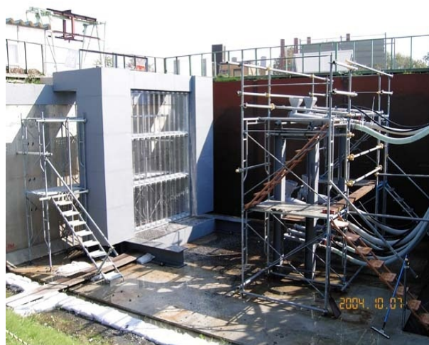
寒地土研角山ヤード放水実験
