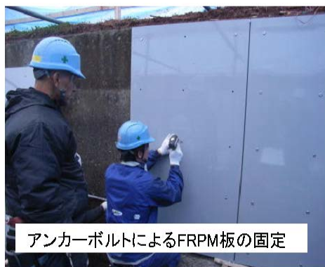
写真-2 FRPM板の設置状況(水路側壁部)
