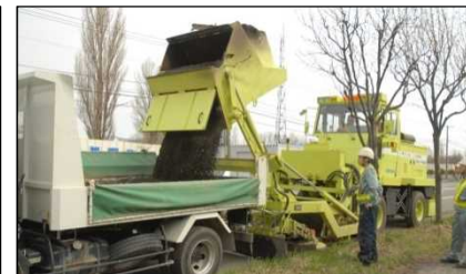
ダンプトラックへの積み込み状況
