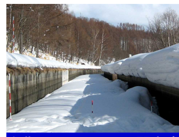
冬期間のコンクリート開水路
