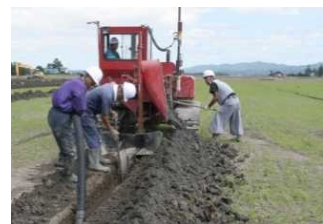
トレンチ掘削による改良
