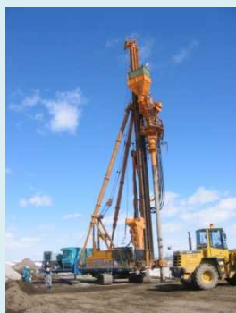
グラベルセメント コンパクションパイル工法
