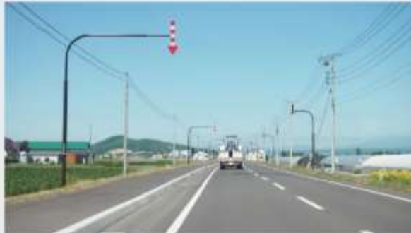
ダークブラウンの標識柱が開放的な景観を損ねている事例。より太いはずの電柱よりも目立つ。
