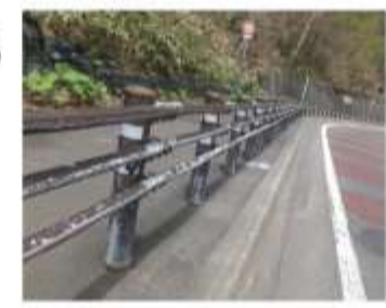
こげ茶系(5YR3/1)の塗装がはがれ、下地の亜鉛めっきの差が目立って見える事例
