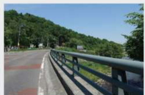
緑みのグレー(美笛グリーン) 5G4/0.8程度 高欄; 国道453号
