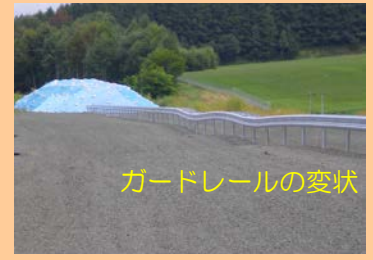
路面の沈下
