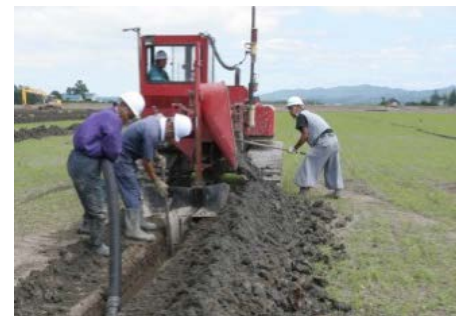
トレンチ掘削による改良
