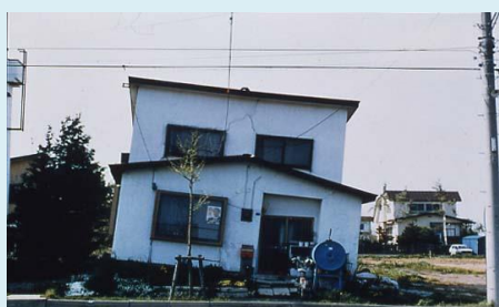
沈下による家屋の傾き
