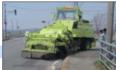
路面清掃作業状況
