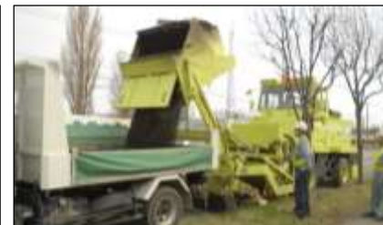
ダンプトラックへの積み込み状況
