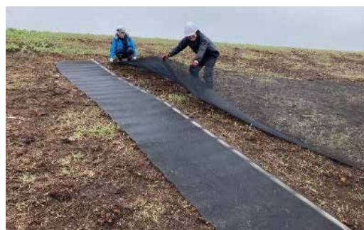
メッシュシートの敷設
