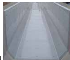
農業用水路 施工事例
