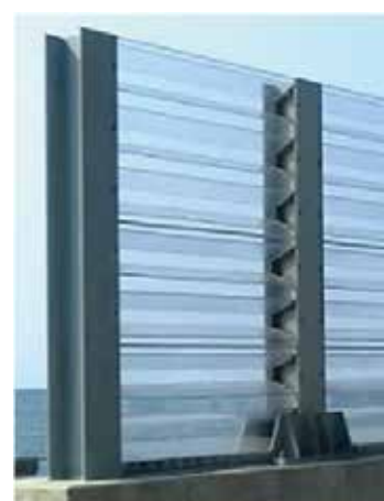
道路側から見た柵の形状
