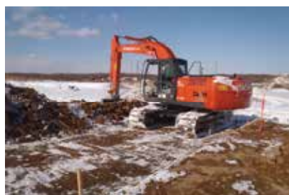
冬期土工の施工状況
