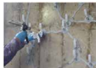
ひび割れ注入工法
