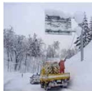
片持式の雪落とし作業
