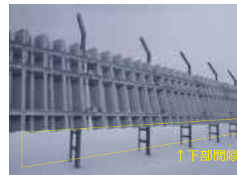
設置状況（石狩吹雪実験場）
