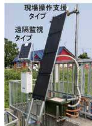
樋門への設置状況（厚別川）
