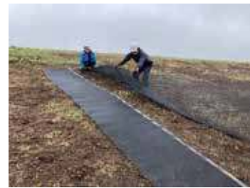
メッシュシートの敷設
