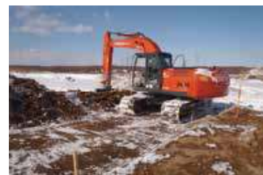
冬期土工の施工状況
