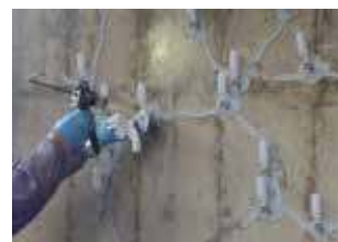
ひび割れ注入工法
