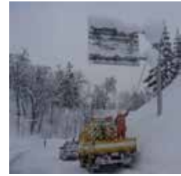
片持式の雪落とし作業
