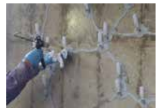
ひび割れ注入工法
