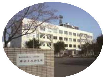
寒地土木研究所庁舎
