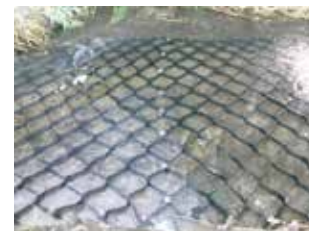
ネットの施工状況
