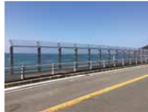
設置状況 (一般国道202号 佐賀県唐津市)
