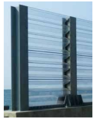
道路側から見た柵の形状
