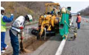
道央自動車道でのトレンチャーによる掘削施工状況
