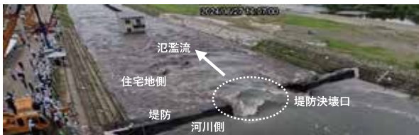
実物大規模の破堤実験（北海道開発局と共同で実施）
