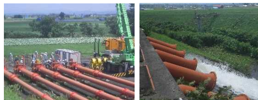
図-1 救急排水機場外観
