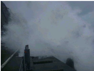
防波フェンス設置前の越波状況
