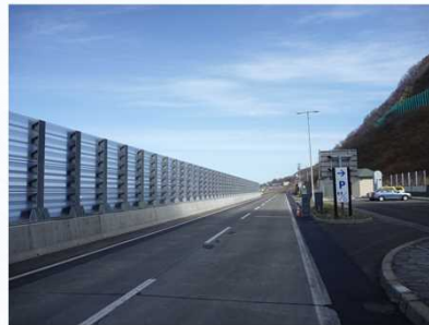
平成23年度防波フェンス設置
