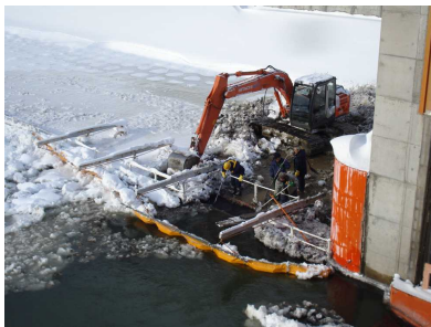
水道取水口に堆積した晶氷除去の様子 (2013年1月:写真は名寄市提供)
