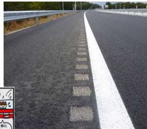
▲ 自専道の路肩に設置された既存規格のランブルストリップス (切削横幅: 150mm 深さ: 15mm)
