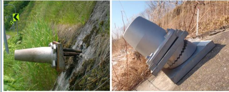
凍上によるグラウンドアンカー工の損傷事例
