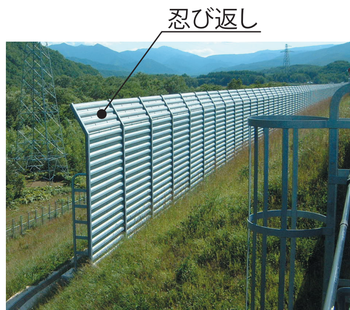
▲吹き止め式防雪柵
